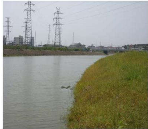
完工后一段时期部分区段绿草覆盖
