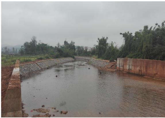
图 2-5 干砌石护岸完工及完工后一段时间效果图
