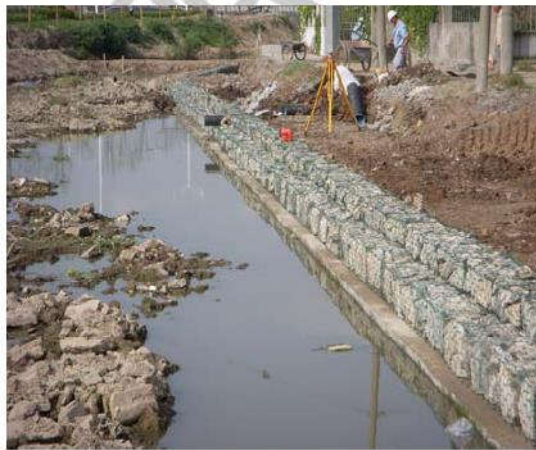
固滨笼摆放及回填土施工水准测量
