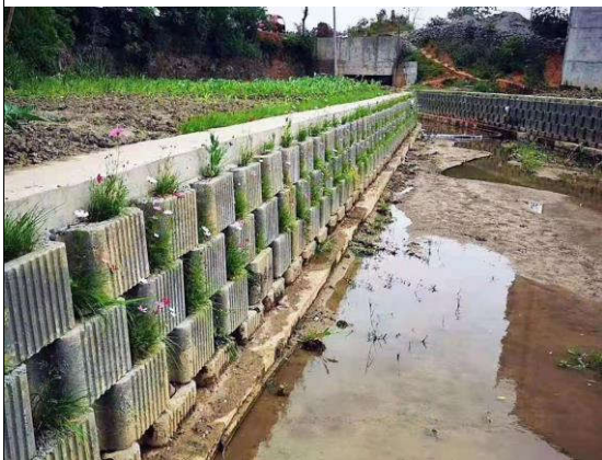
图 2-6 砼生态挡墙护岸完工及完工后一段时间效果图
